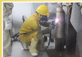
解体作業の習熟
