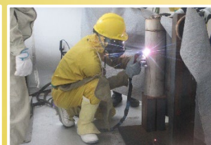
解体作業の習熟
