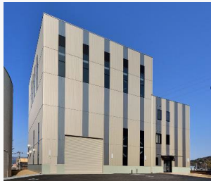
ふくいスマートデコミッショニング 技術実証拠点 (スマデコ) (廃止措置技術実証試験施設)
