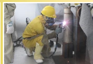
解体作業の習熟
