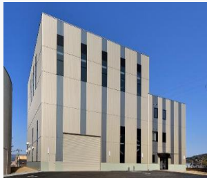
ふくいスマートデコミッションング 技術実証拠点 (スマデコ) (廃止措置技術実証試験施設)
