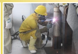
解体作業の習熟
