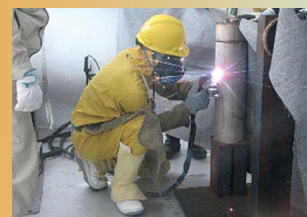
解体作業の習熟
