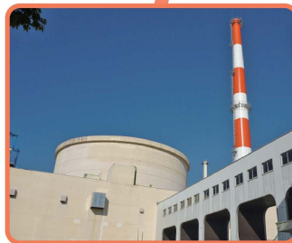
高速実験炉 常陽 (原子炉)
